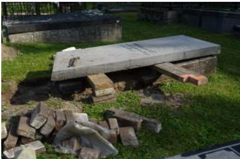
Een deel van het muurwerk had alle samenhang verloren. Nadat de zerk deels is gelicht wordt het muurwerk met de oude stenen hersteld.
