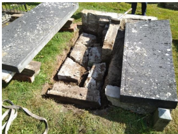
Werkzaamheden aan het monument Holthuis-Staal. Daar er geen wapening was aangebracht, viel de betonnen onderbouw in grote brokstukken uiteen.
